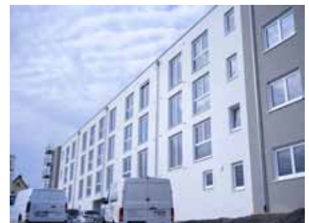
Noch sind zahlreiche Handwerker auf der Baustelle, um die letzten Arbeiten an dem Gebäude auszuführen.
