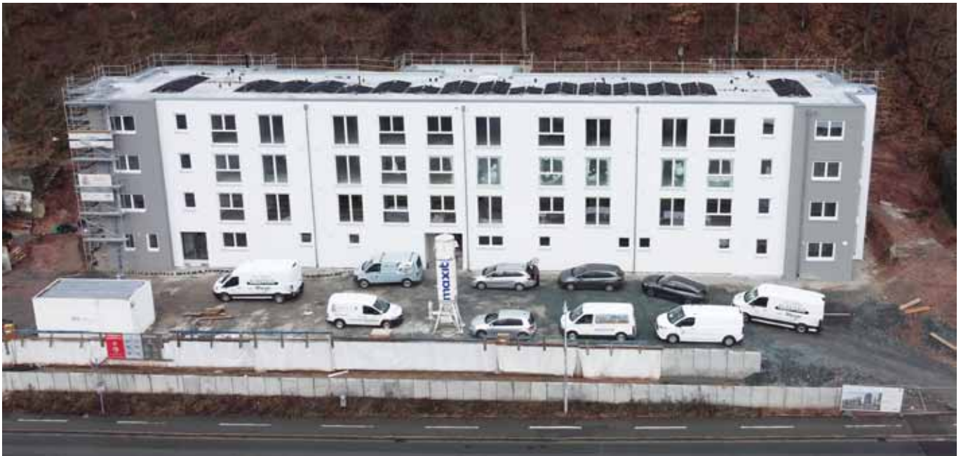
Der Neubau in der Hofer Straße sieht jetzt schon beeindruckend und einladend aus. Auf dem Dach ist die PV-Anlage erkennbar, die ebenfalls schon installiert ist.
