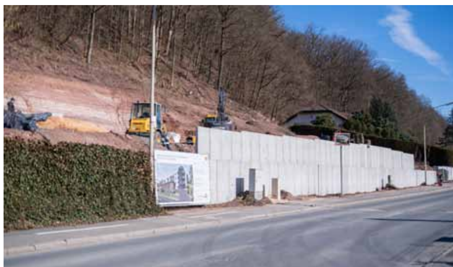
Um den Straßenverkehr nicht zu beeinträchtigen, wurden Betonpalisaden errichtet, die verhindern, dass Erdbrocken oder Steine auf den Gehweg oder die Fahrbahn der Hofer Straße rutschen.
