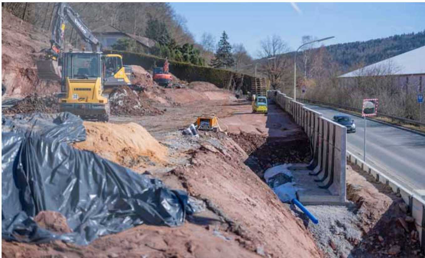
Noch laufen die Vorarbeiten am Baugrund. Doch schon bald wird es losgehen mit der Errichtung des Gebäudes.
