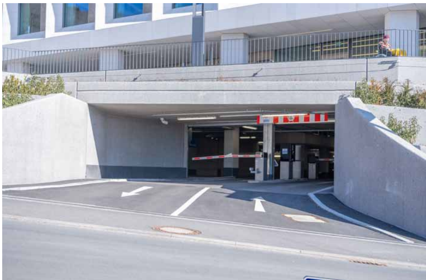
Die Zu- und Ausfahrt direkt unter dem Neubau West.
