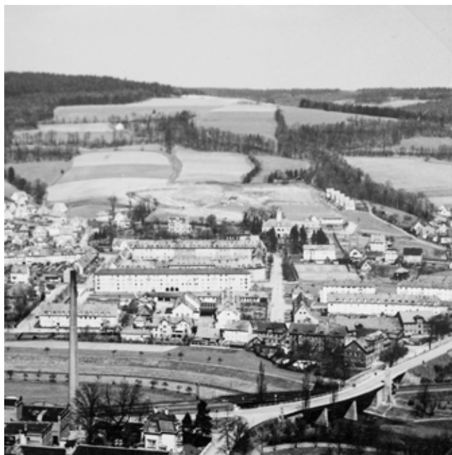
Ein Anblick, den man sich heute kaum mehr vorstellen kann: Vom Burgberg aus überschaute man die Bleich und im Hintergrund auf den Baugrund, der für den Bau des Krankenhauses gerade vorbereitet wird.
