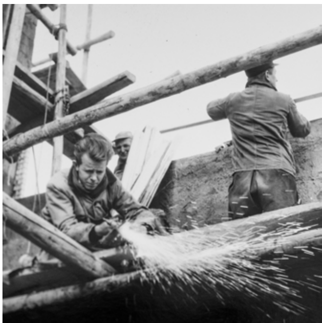
Arbeiten auf der Krankenhausbaustelle: Von September 1958 bis September 1960 wurde der erste Trakt des heutigen Klinikum Kulmbach errichtet.
