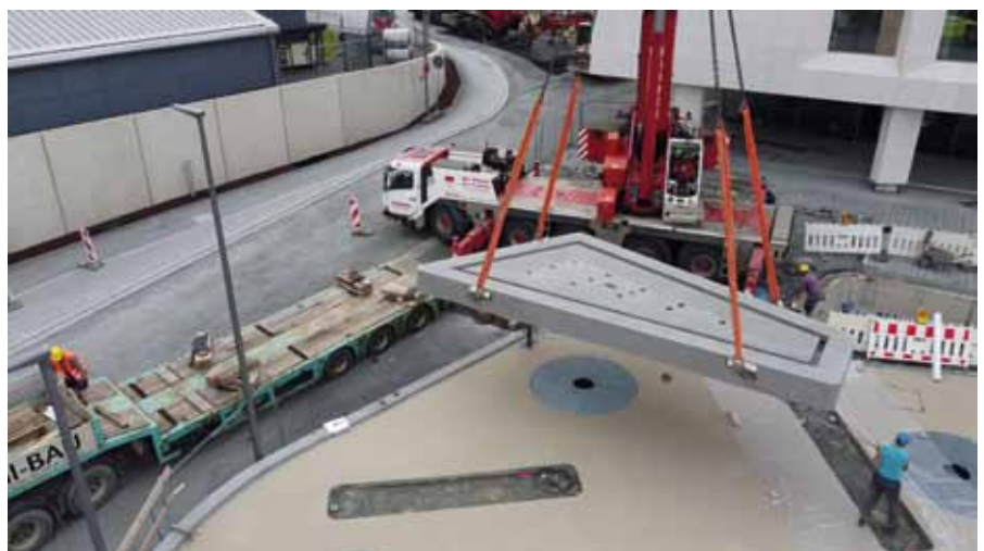
Gefertigt wurde der Brunnen von der Firma Göhl Bau aus Burgkunstadt. Den Kran hat die Firma Merkel Autokrane aus Burgkunstadt gestellt. Profis waren am Werk: Es hat nicht einmal eine Stunde gedauert, bis die massive Betonplatte an Ort und Stelle war.
