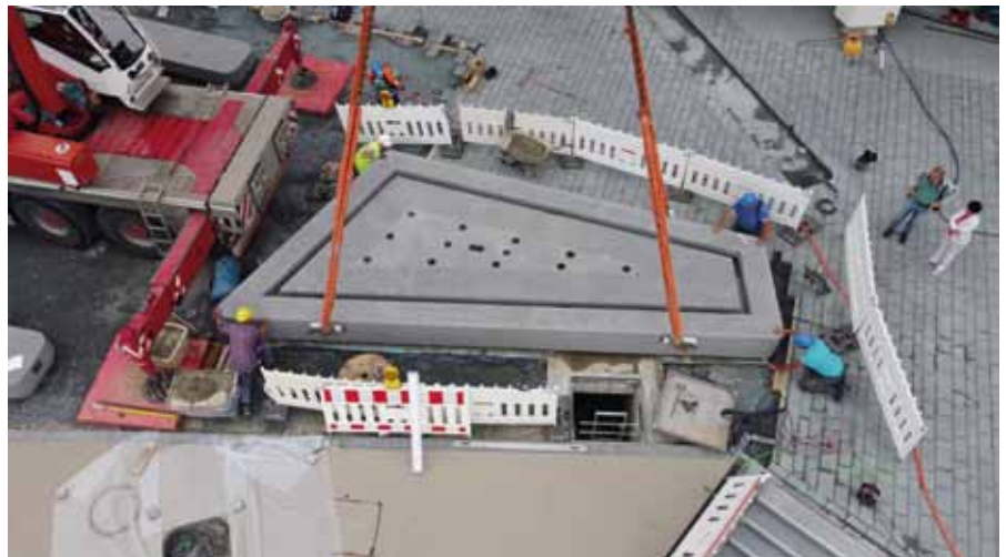
Mit Hilfe eines Schwertransports und eines Schwerlastkrans ist Ende Juni der neue Brunnen für den Vorplatz angeliefert und in seine endgültige Position gehievt worden. Die Technik darunter war längst vorher vorbereitet. 27,5 Tonnen wiegt der Brunnen, der zu einem Blickfang im Eingangsbereich werden wird.
