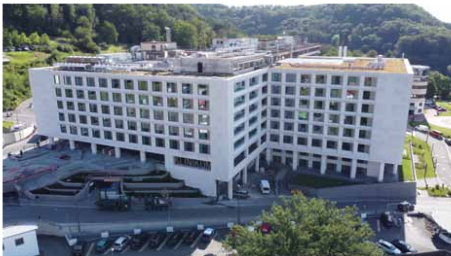
Ein imposantes Bauwerk ist der Neubau West mit seiner Natursteinfassade und der außergewöhnlichen – mehrfach preisgekrönten – Wabenfassade.
