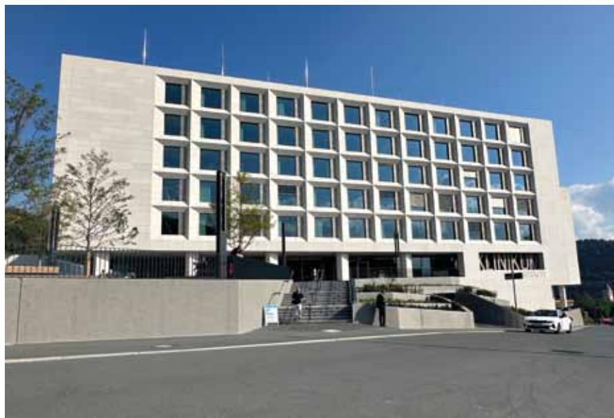
Aus Portugal stammt der weiße Naturstein, der der Fassade des Neubaus West ein ganz besonderes Flair verleiht.
