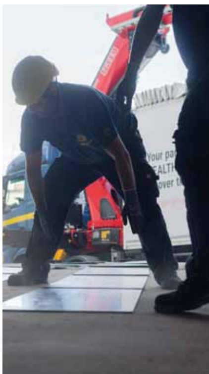
Eigens wurde eine Rampe gebaut und befestigt. Stahlplatten wurden verlegt, damit das Gerät nicht einsinken kann, wenn es ins Gebäude geschoben wird.
