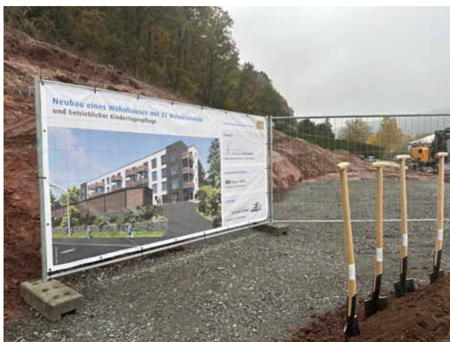
Wie das Haus aussehen wird, das konnte man auf den großen Transparenten sehen, die auf der Baustelle zur Information aufgestellt waren.
