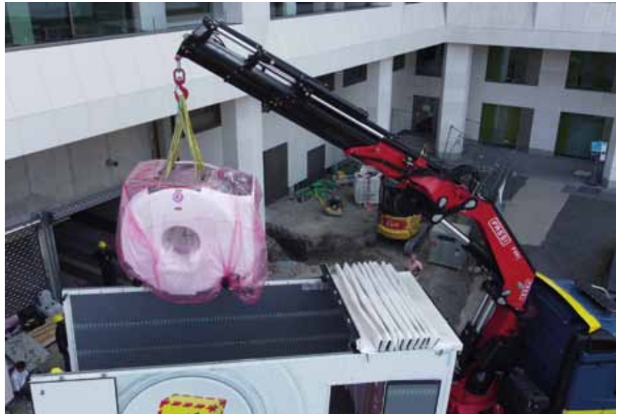
So hat alles angefangen: Mit einem Kran wurde der fünf Tonnen schwere Koloss vom Lkw gehievt.
